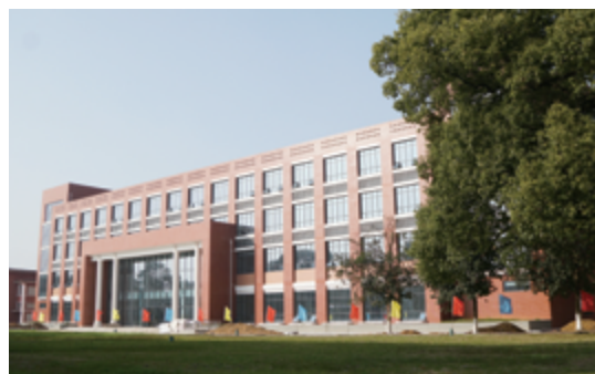
学校实训大楼
