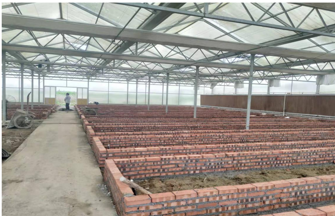
建设育秧工程
