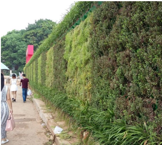
城市墙体绿化装置
