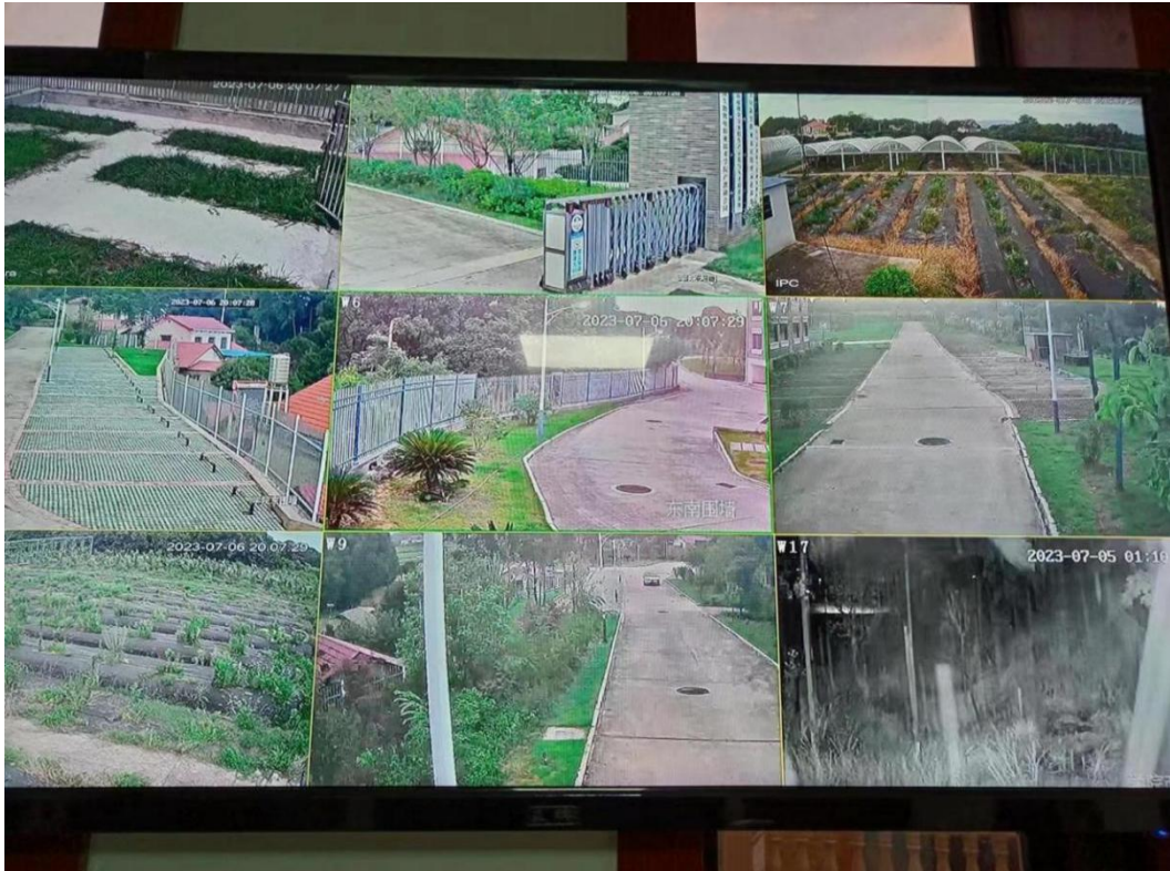
图 1 监控设施设备运作情况
