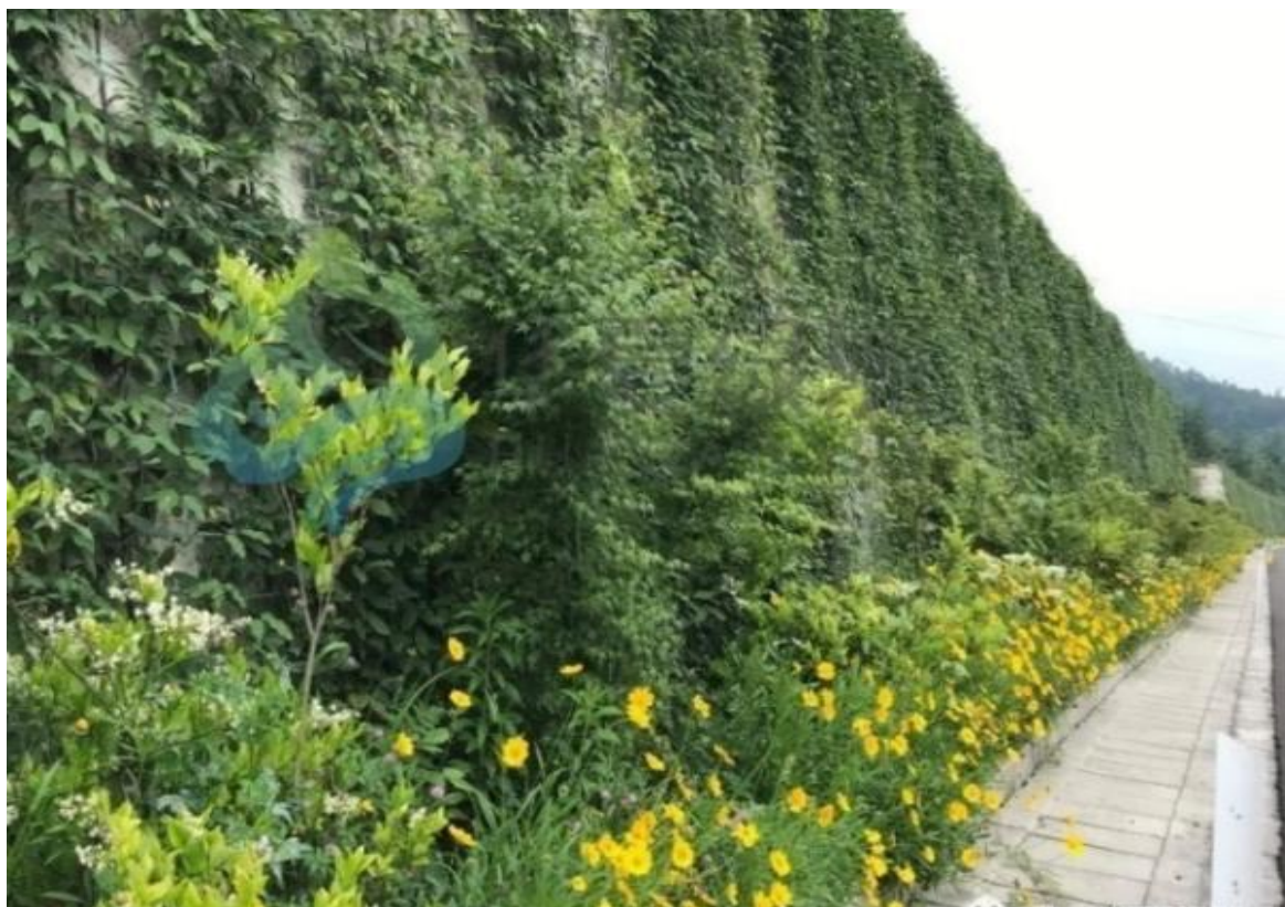
图 3-8 藤本植物道路护坡长张高速
