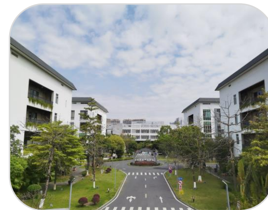
深圳领亚工厂 (秋收楼&冬藏楼)
